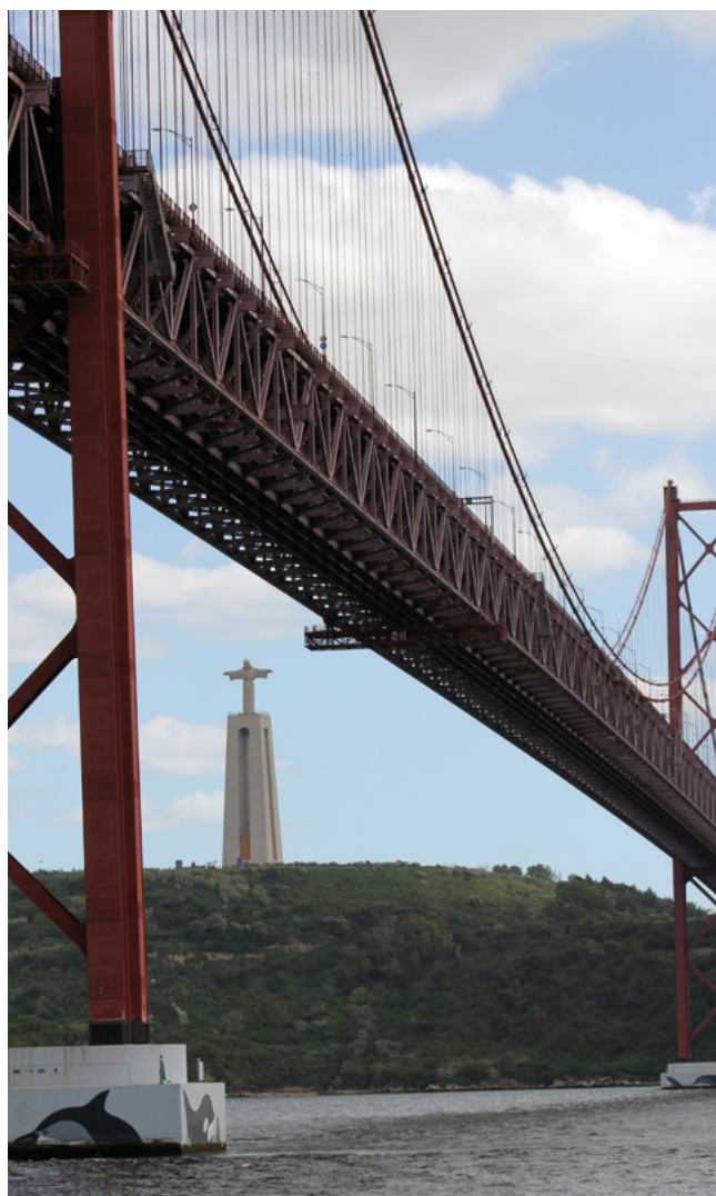
Em cima: Ponte 25 de abril sobre o Tejo, com vista do Cristo Rei na outra margem. Foto arquivo MSA 2018.
